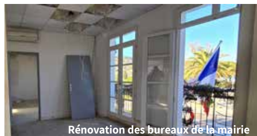
Rénovation des bureaux de la mairie
